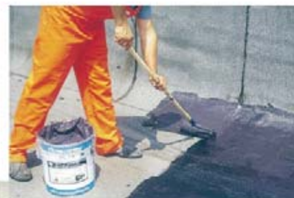
Per riparare vecchie guaine bituminose
