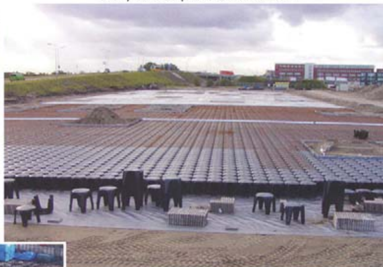
Intercapedine aerata per edificio ad uso industriale
