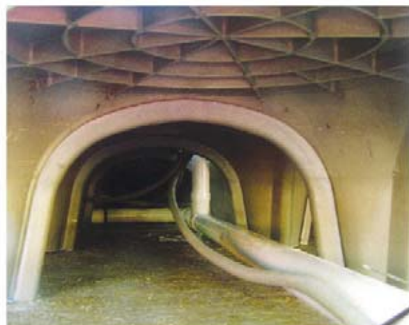
Esempio di passaggio utenze
